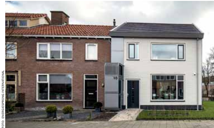
Vorher – nachher: Reihenhaus in Gorredijk (NL) mit Net-Zero-Gebäudehülle und Gebäudetechnik-Modul.
