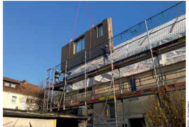
Hameln, Quartier Kuckuck: Das erste Fassadenmodul wird montiert.
