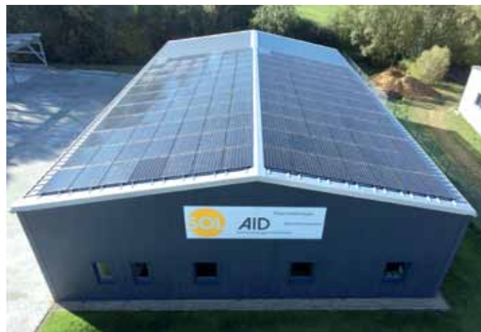
Die Module mit 50 kW Leistung sind in Ost-West-Ausrichtung auf dem Firmengebäude montiert.
