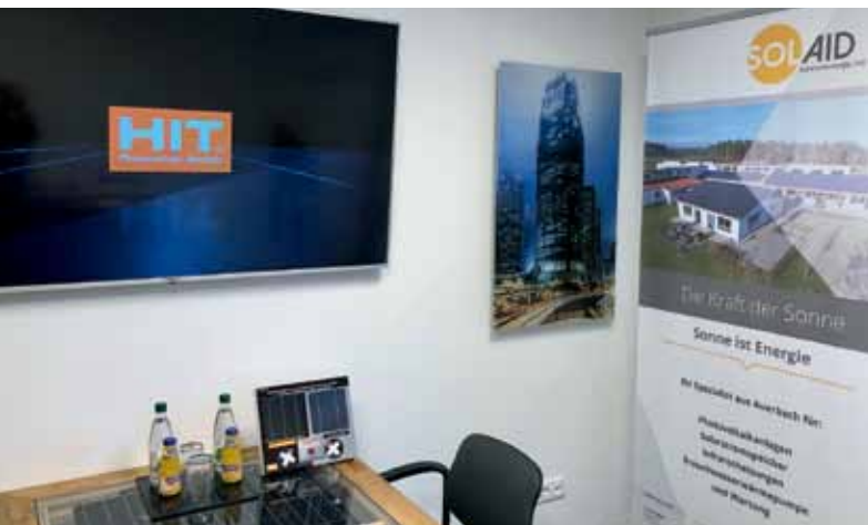
Anstelle eines Heizkörpers gibt das Infrarotpaneel mit dem Wolkenkratzer darauf im Besprechungszimmer Wärme ab.
