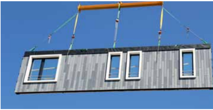
Hochwärmegeädämmte Gebäudehülle: Zum Einsatz gekommen sind komplett vorgefertigte Vorhangfassaden in Holztafelbauweise.
