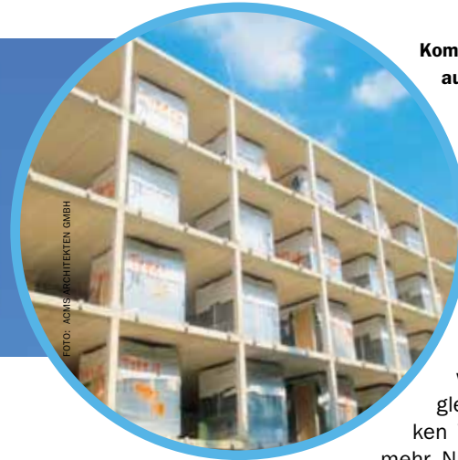
Hochwärmegeädämmte Gebäudehülle: Zum Einsatz gekommen sind komplett vorgefertigte Vorhangfassaden in Holztafelbauweise.
