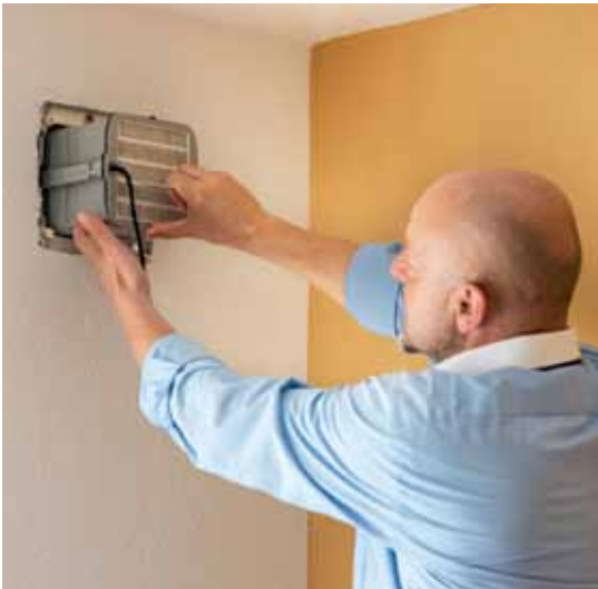
Bernd Schäfer, Gebietsverkaufsleiter von Stiebel Eltron, bei der Entnahme des Innenteils des dezentralen Lüftungsgerätes LWE 40
