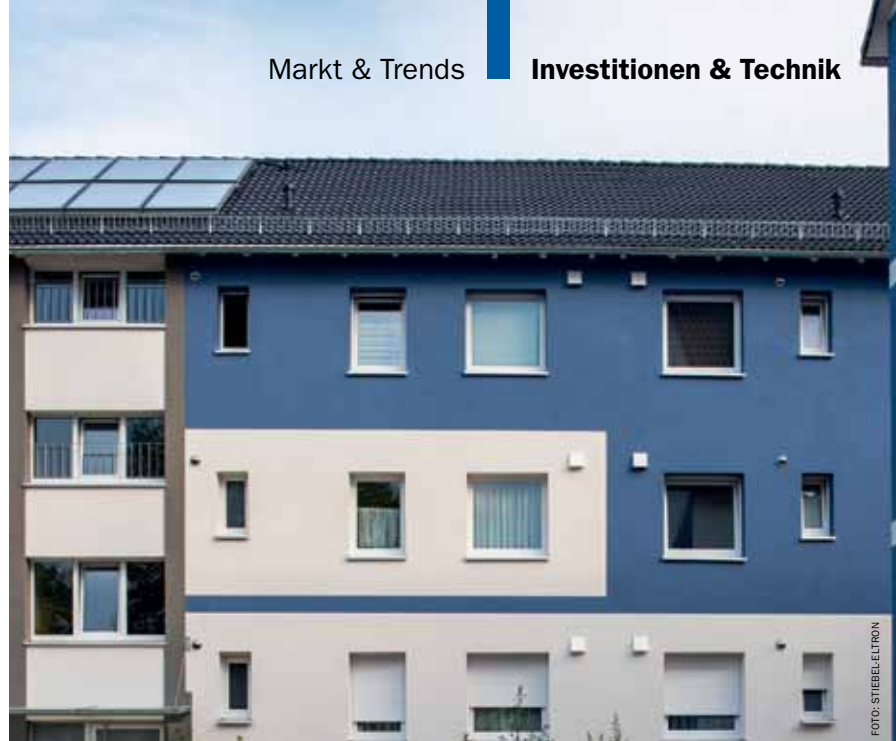
1957 wurden die beiden Gebäudeteile errichtet, die jetzt von der Baugenossenschaft Langen saniert wurden. Nachträglich wurde zum Beispiel dezentrale Wohnungs Lüftung mit Wärmerückgewinnung installiert.
