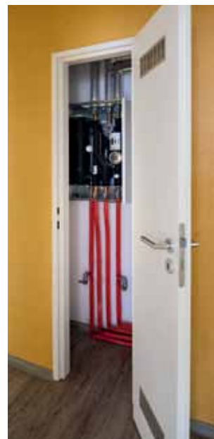
Die Wohnungsstation WSP von Stiebel Eltron: Hier wird die Wärme des zentralen Erzeugers an das Heizsystem übergeben und für die hygienische Warmwasserbereitung genutzt.
