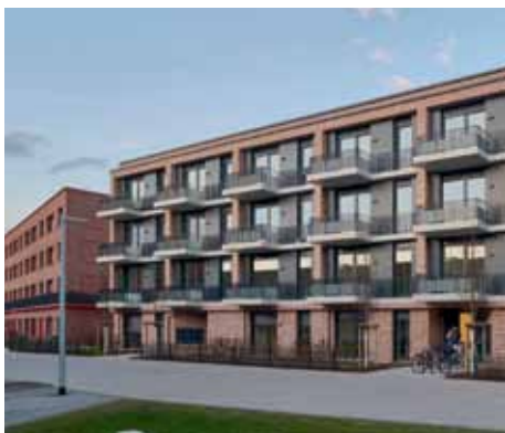
Die Südseite des Wohnungsbaus kennzeichnet sich in den Obergeschossen durch großmaßstäbliche Öffnungen.
