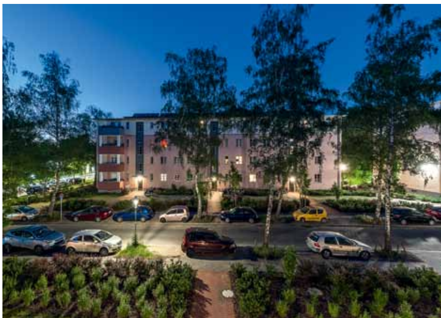
Das Quartier der Märkischen Scholle in Berlin Lichterfelde Süd: Durch den Einsatz regenerativer Energietechnik wurde der CO 2 -Fußabdruck der Wohnanlage von 60 Kilogramm pro Quadratmeter Wohnfläche und Jahr auf 11,5 Kilogramm reduziert.
