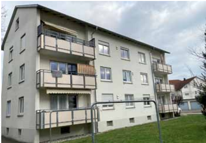
Das Mehrfamilienhaus in Bad Saulgau aus dem Jahr 1964 vor der energetischen Sanierung.
