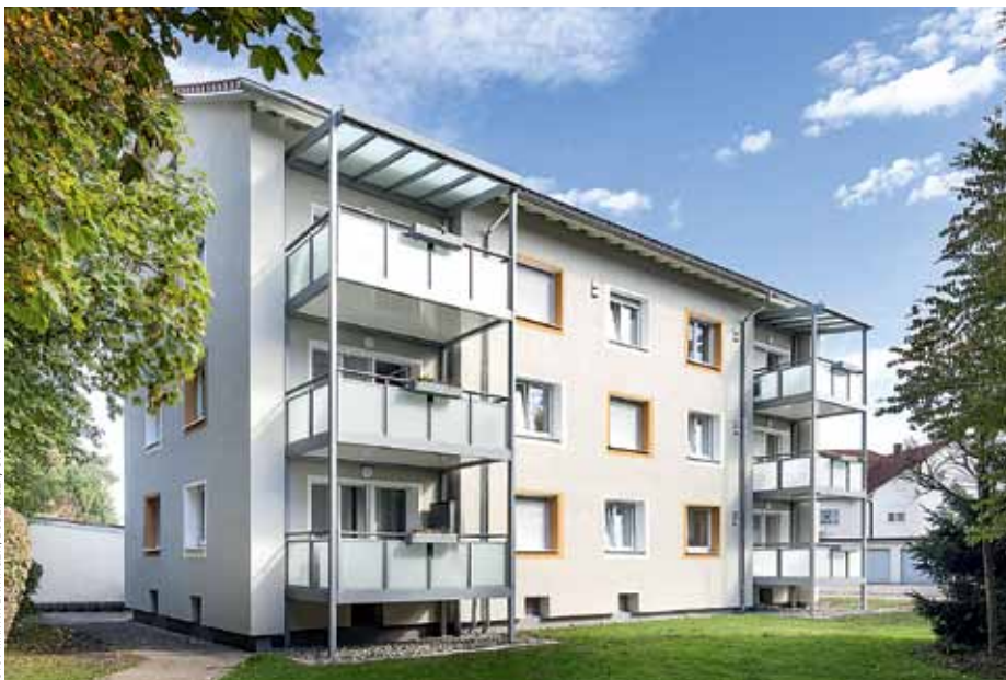
Das Mehrfamilienhaus in Bad Saulgau nach der umfassenden energetischen Sanierung inklusive Fassadendämmung, neuem Dach und modernen Vorstellbalkonen.
