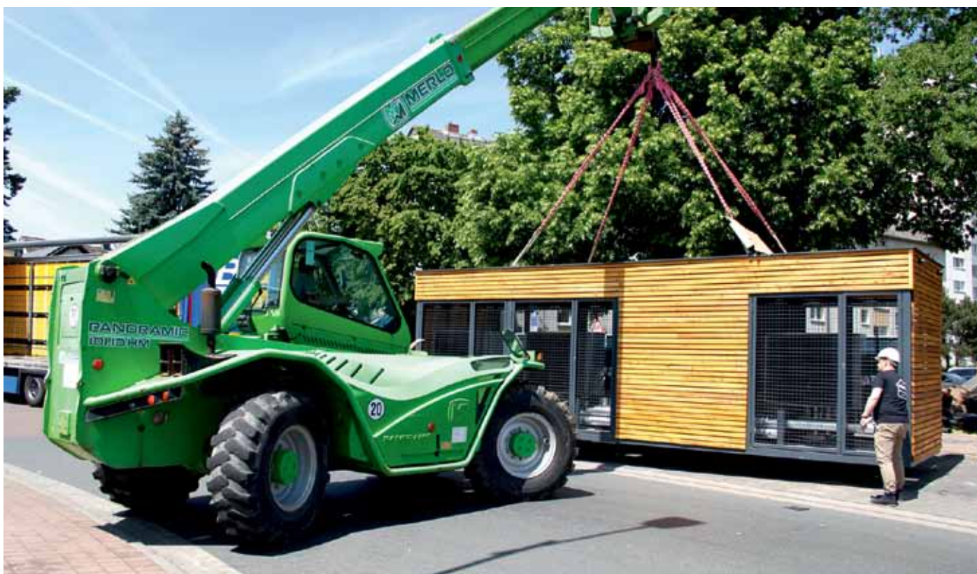
Die vorgefertigten Energiemodule werden vor Ort montiert und installiert.
