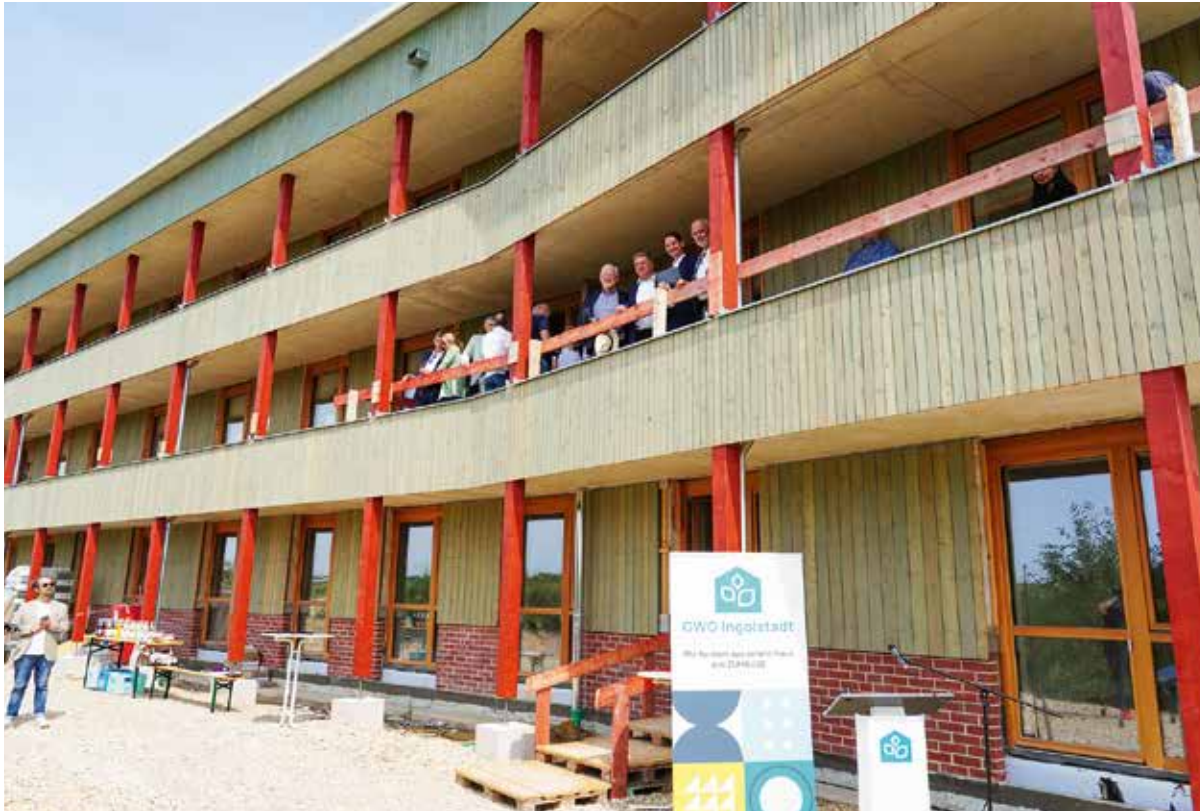
Das dreigeschossige Wohnhaus der GWG Ingolstadt mit 15 Wohnungen kommt ohne Heizung aus.
