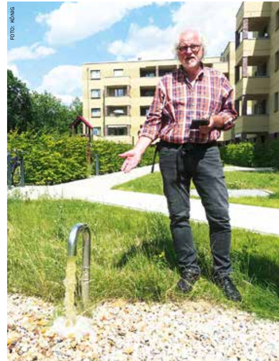
Der unterirdische Speicher wird durch einen Überlauf entlastet.
