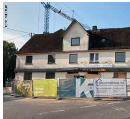
Der Westerwälder Hof vor Beginn der Sanierung.
