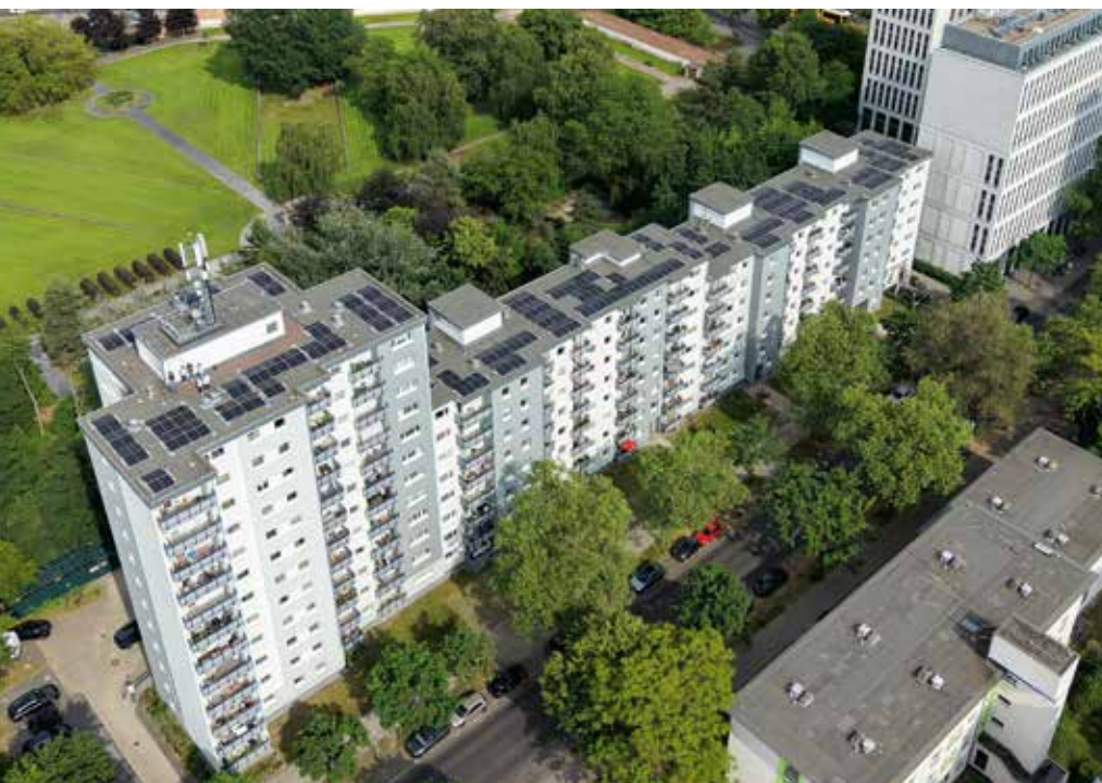
So sieht die Photovoltaik-Anlage von oben aus.
