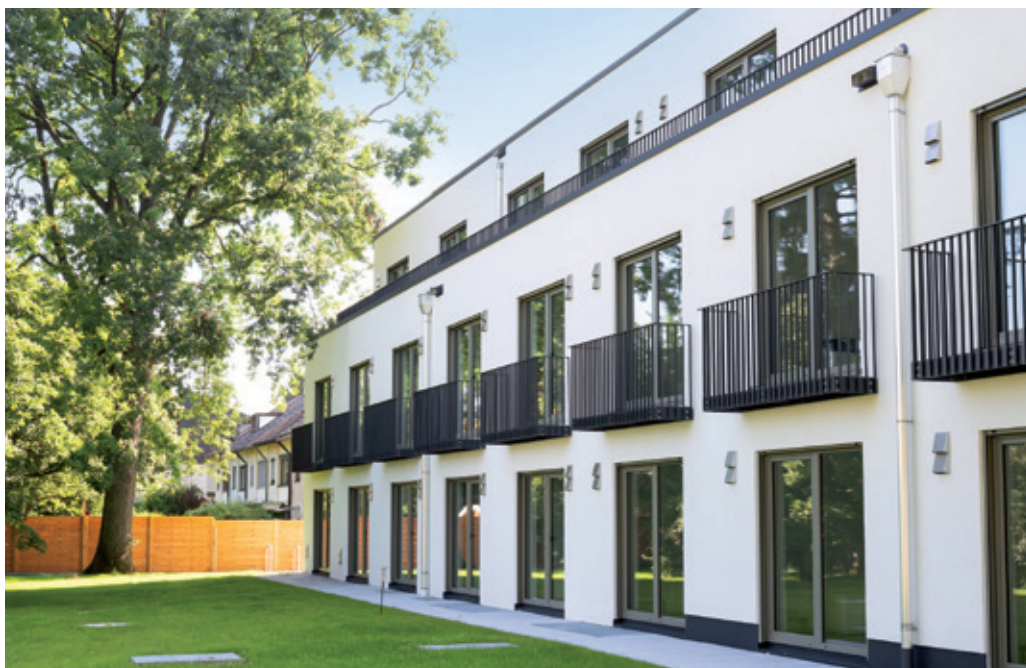
Apartmenthaus der FMG in München
